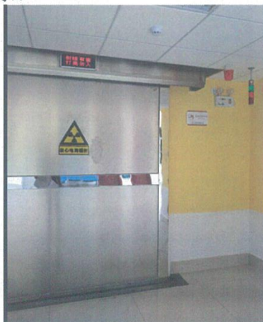
图 4-1 电离辐射警告标志设置情况
